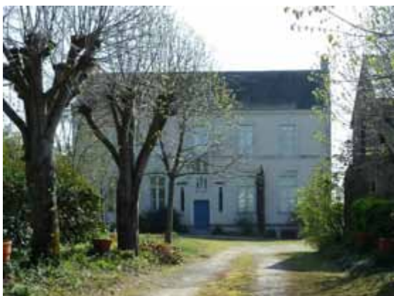
Rue des Grands Coteaux
